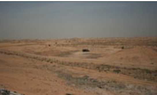
Start of the earthworks at cell 1a Beginn der Erdarbeiten auf dem Gelände Zelle 1a
