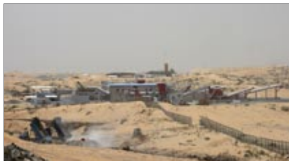
CDW plant and waste removal Baurestverwertungsanlage und Müllumladung
